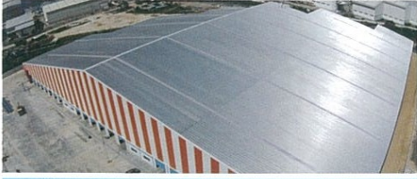
โครงการรัตนาดิแลนด์ ถ. บางนา-ตราด
