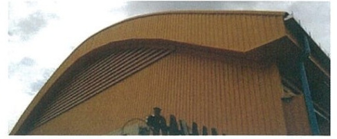
โรงงานบางกอกทูล เพชรเกษม 99
